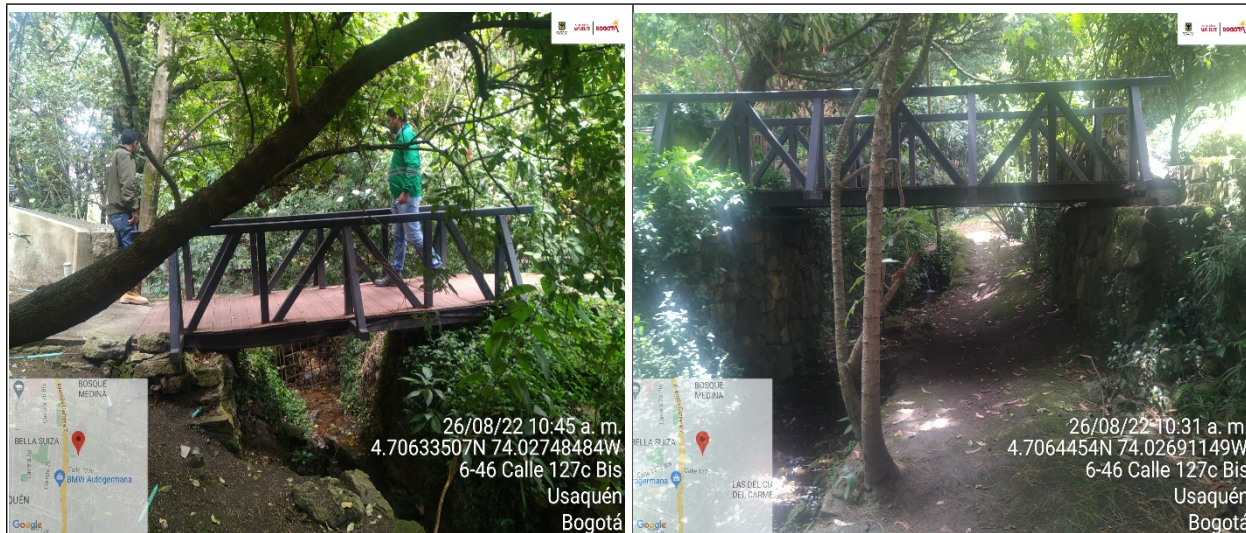
Fotografías No. 3 - 4. Instalación de puentes para paso peatonal sobre el cauce la Quebrada Trujillo, sin registro de solicitud para Permiso de Ocupación de Cauce – POC.
