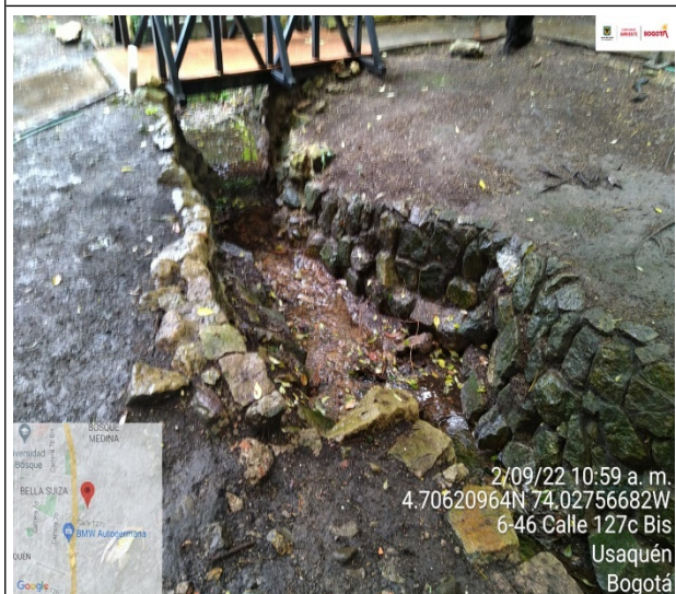
Fotografías No. 13 – 14. Intervención del talud de la Quebrada Trujillo con rocas decorativas a lo largo del tramo correspondiente al predio de nomenclatura urbana Calle 127c Bis # 6 – 46, de la localidad de Usaquén.
