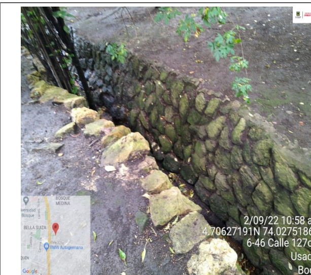
Fotografías No. 13 – 14. Intervención del talud de la Quebrada Trujillo con rocas decorativas a lo largo del tramo correspondiente al predio de nomenclatura urbana Calle 127c Bis # 6 – 46, de la localidad de Usaquén.
